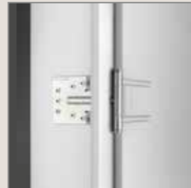
Im Mauerwerk verankerte Sicherheitsbänder erschweren das Aufhebeln.
